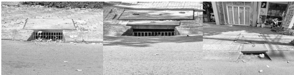
Hình 4. Các cửa thu nước kiểu thu bó vỉa đang được sử dụng trên các tuyến đường phường 3, thành phố Vĩnh Long
