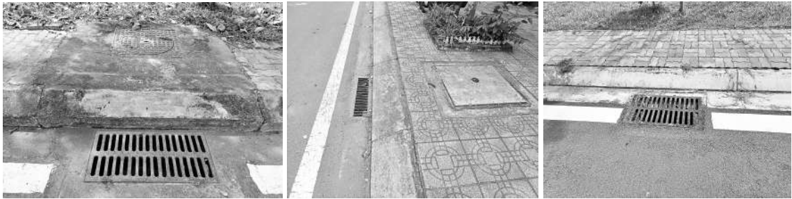
Hình 5. Các cửa thu nước kiểu thu mặt đường có lưới chắn rác đang được sử dụng trên các tuyến đường phường 3, thành phố Vĩnh Long
